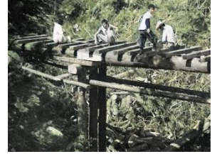
橋を架ける工事の様子
